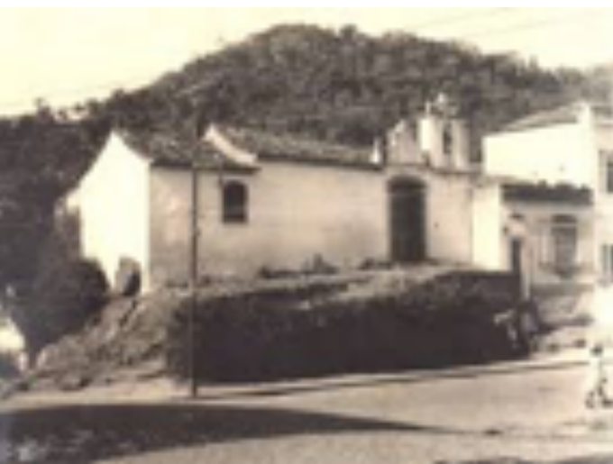
Fig 1. Capela de Santa Luzia. 1940. Localizada no Centro Histórico de Vitória - ES. Disponível em < www.morrodomoreno.com >. Acesso em 5 junho de 2017.
