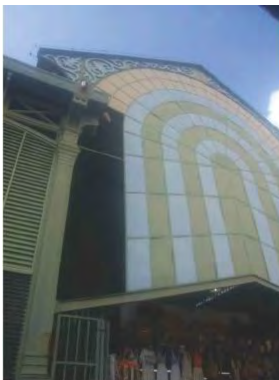
Figura 3 – Mercado de São José, fachada principal
