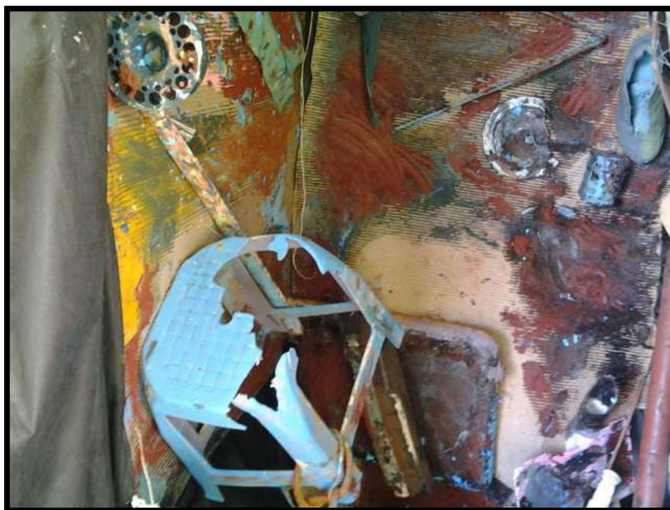
Fotografia 13 – Instalação do painel no banheiro da escola
