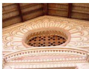
Foto 5. Detalhe da entrada principal
